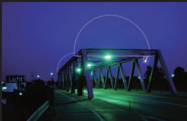
HORST RELLECKE (*1951 in Duisburg) „Regenbogenbrücke“, 2004, Standort: Radbodbrücke, Hafenstraße Koordinaten: 51.67935455 B | 7.77692556 L
